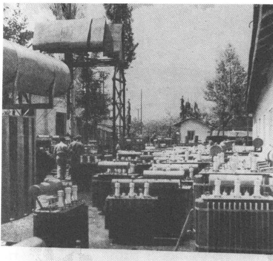
Трансформаторна фабрика на "4-ти километър", София
